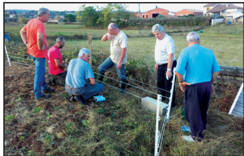
Pose d'une clôture électrique
